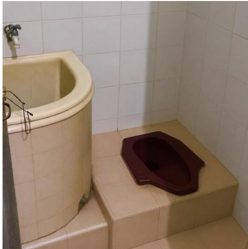
Air Bersih dan Jamban
