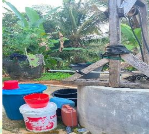
Gambar 6. Dinding Sumur Gali Terbuat Dari Semen Dan Batu Bata
