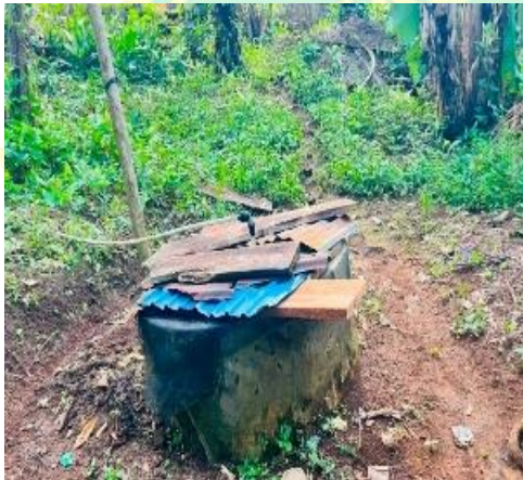
Gambar 7. Lantai Sumur Gali Masi Tanah
