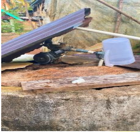
Gambar 5. Penutup Sumur Gali Terbuat Dari Bahan Kayu Dan Di Tutup Abseng
