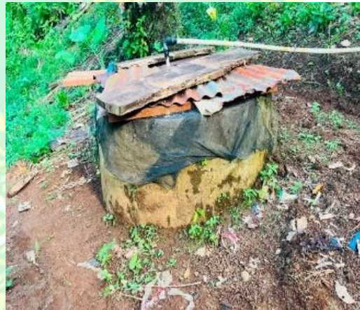
Gambar 8. Sumur Tidak Menggunakan Saluran Pembuangan Air
