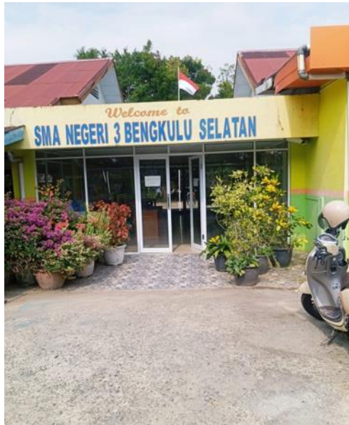
Gambar 2.7 Tampak depan SMA Negeri 3 Bengkulu Selatan
