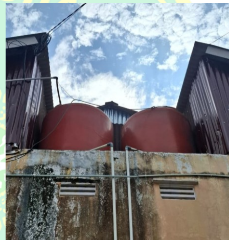
Kondisi di kos B
