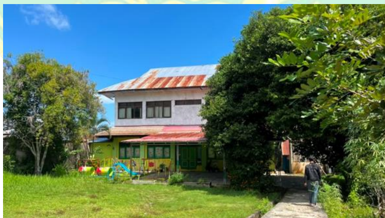
Gambar 1. 1 Bangunan 2 Lantai TK Seroja Aisyiyah Kota Bengkulu
