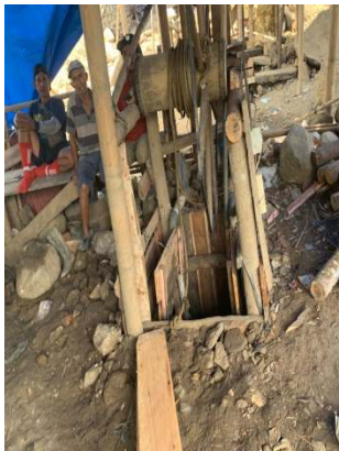
Kondisi Lingkungan Kerja
