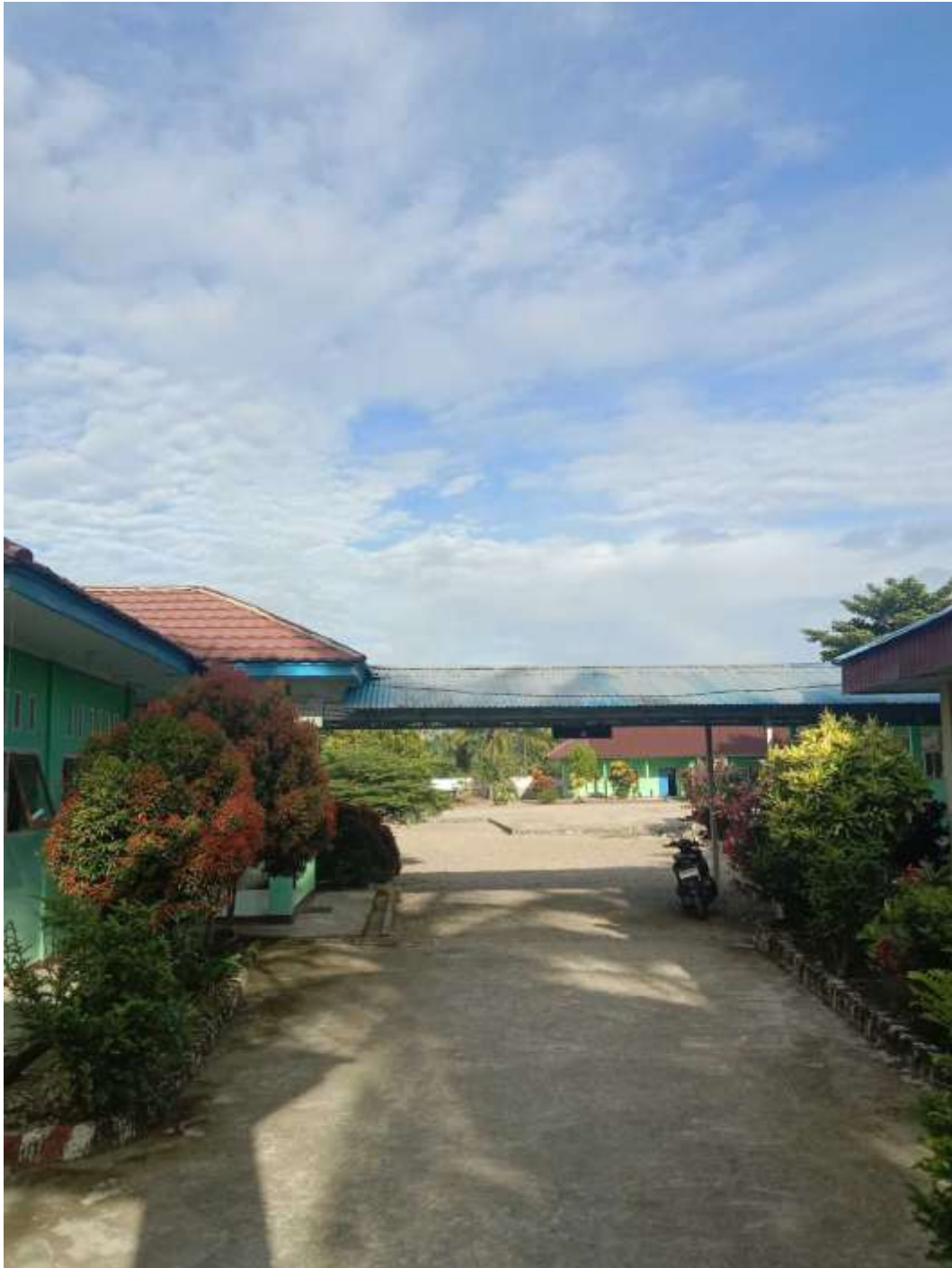
Bangunan SMP Negeri 7 Bengkulu Selatan
