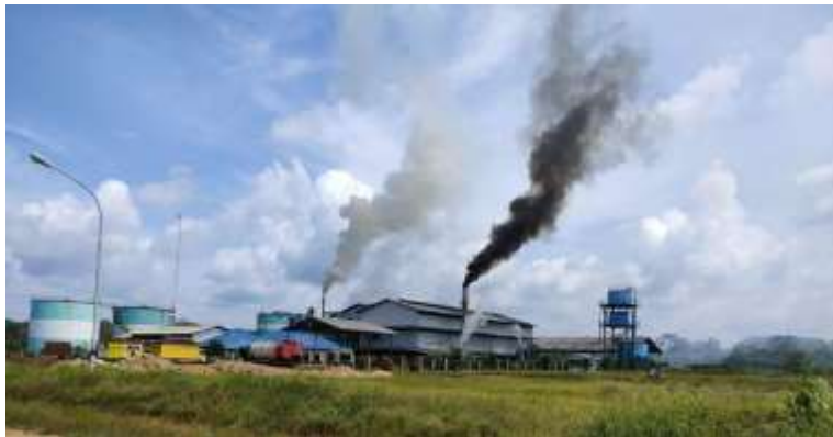
Warga Dusun Tanjung Baringin, Desa Mangupeh, Kecamatan Tengah Ilir, Kabupaten Tebo mengeluhkan bau limbah dan asap pabrik PT SSSA / Metrojambi.com /Suci
